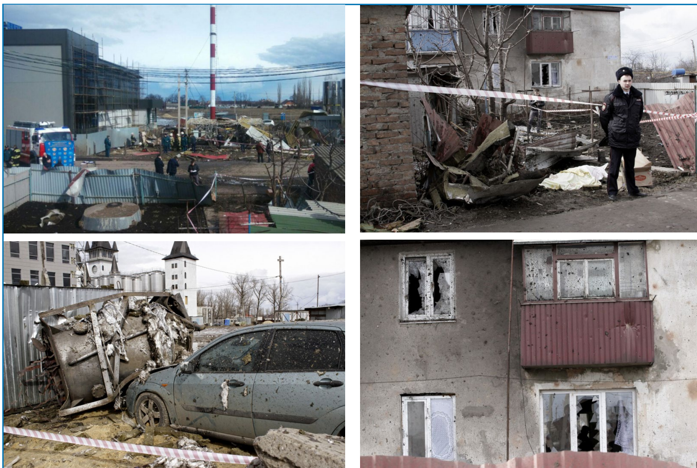
Рисунок 3. Последствия взрыва блочно-модульной котельной под Воронежем.
