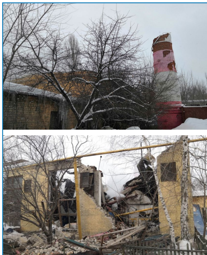
Рисунок 2. Обрушение трубы в котельной Воронежа.
