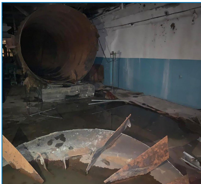
Рисунок 6. Последствия аварийной «опрессовки» бака-аккумулятора в котельной Воронежа.
