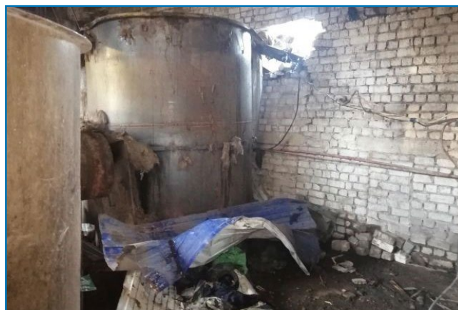
Рисунок 10. Последствия взрыва водогрейного котла в пос. Свеча.
