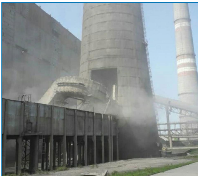
Рисунок 9. Обрушение газохода энергоблока Приморской ГРЭС.
